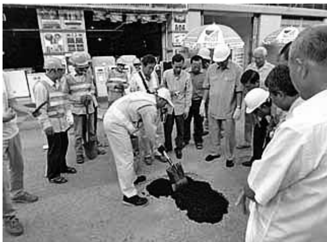
アスファルト補修材の試験施工
